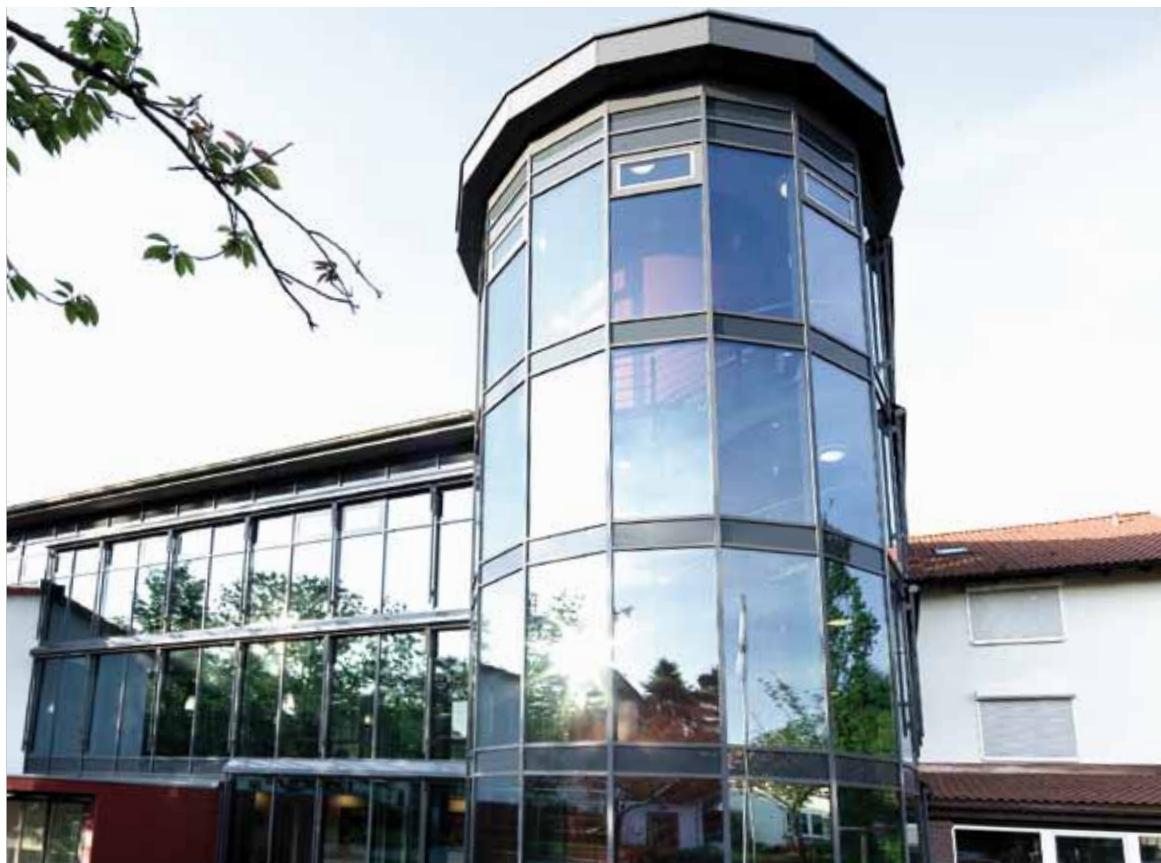
Für die große Glasfassade des Verwaltungsgebäudes der WGW wurde das Vogelschutzglas verwendet.
